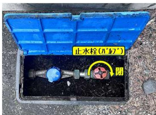
☆メーターBOXの止水栓が壊れている時に、工事店の人が使うバルブBOXです。位置確認と目印をお願いします。いざという時に見つからないと、修理工賃が多くなったりします。
