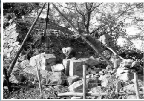
昭和46年豪雨により崩落した出櫓の石垣と復旧作業のようす
