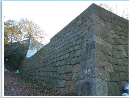
平成15年度から平成27年まで行われた出櫓台の修復工事
