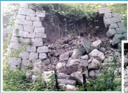
昭和46年豪雨により崩落した出櫓の石垣と復旧作業のようす
